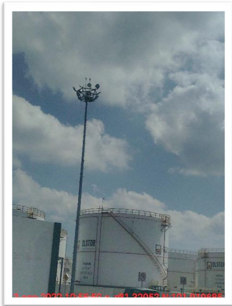
Figura 51. Sistema de pararrayos
